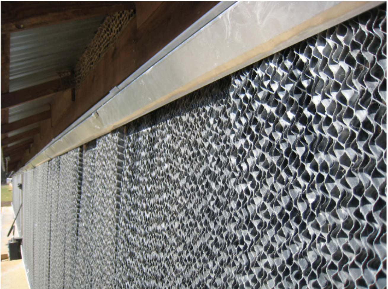
Sustituya los paneles descajados
