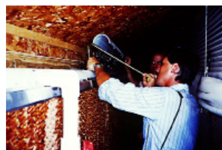
Medición de la canaleta
