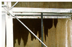
Canaleta obstruída
