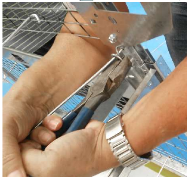
Enrollar alambre refuerzo de piso en la primera columna.
